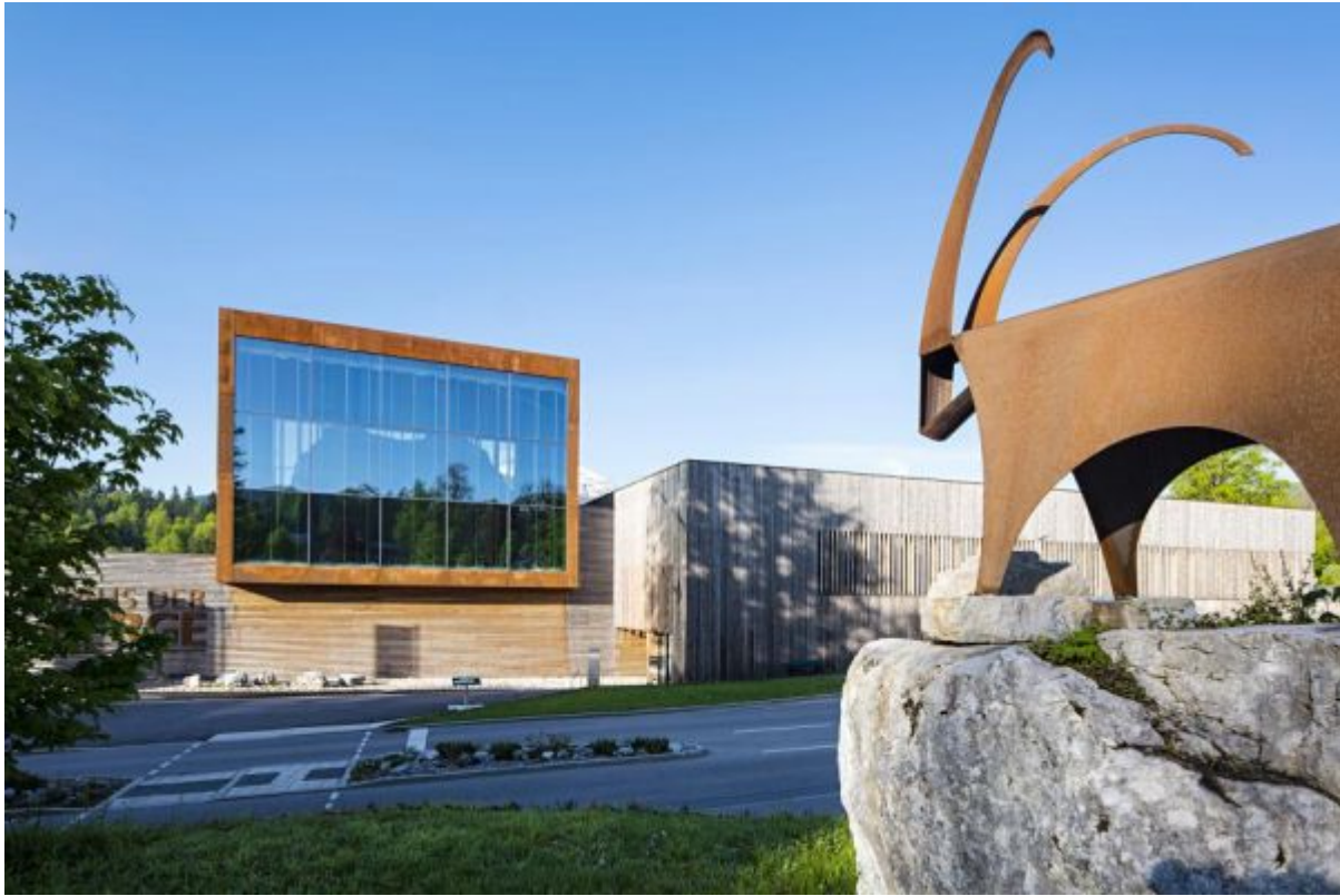
Nationalparkzentrum Haus der Berge
