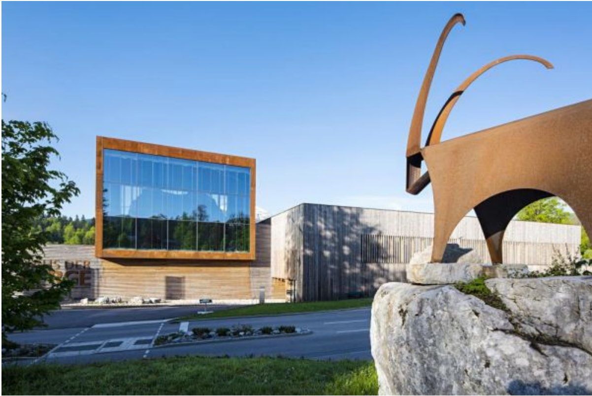
Nationalparkzentrum Haus der Berge
