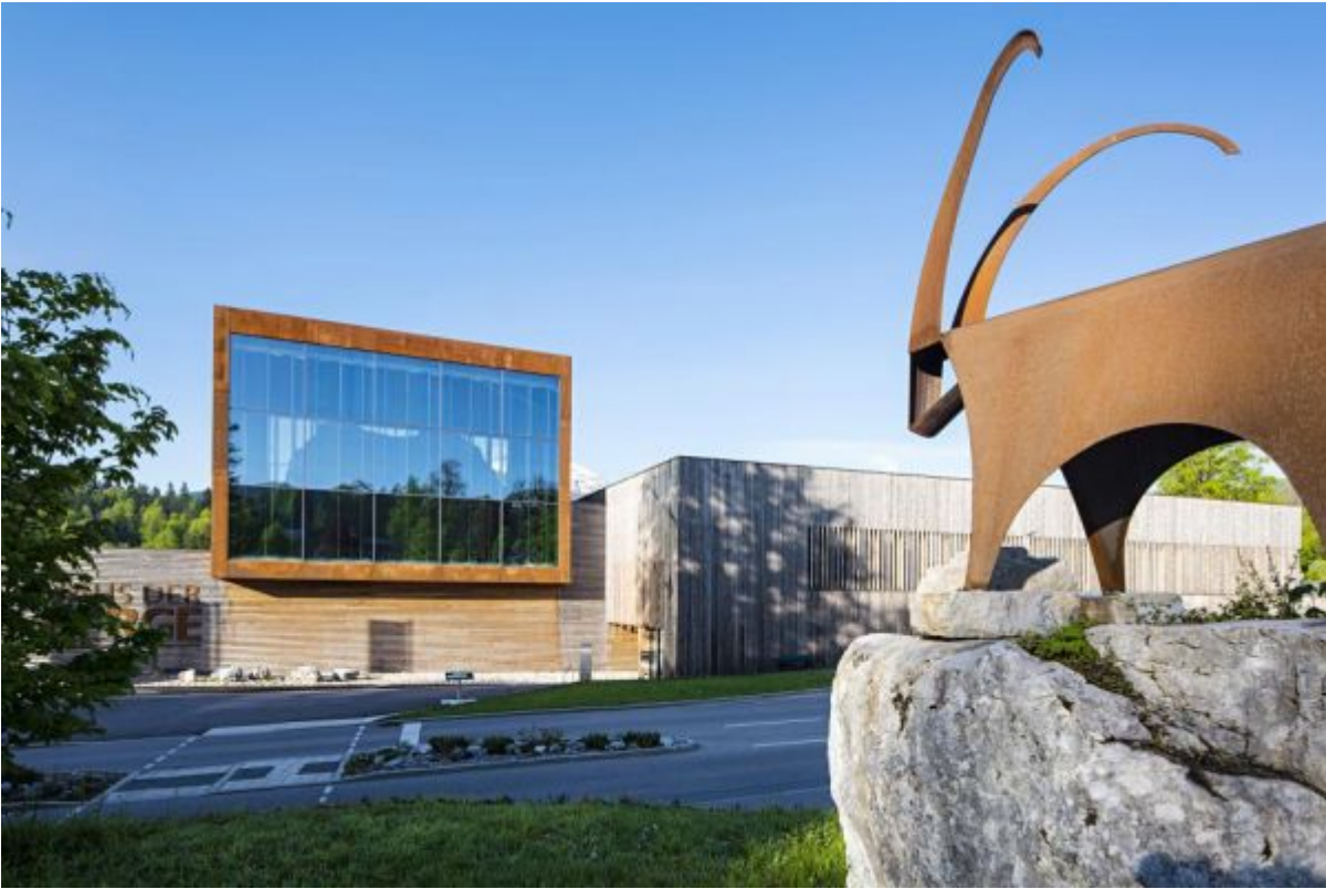
Nationalparkzentrum Haus der Berge
