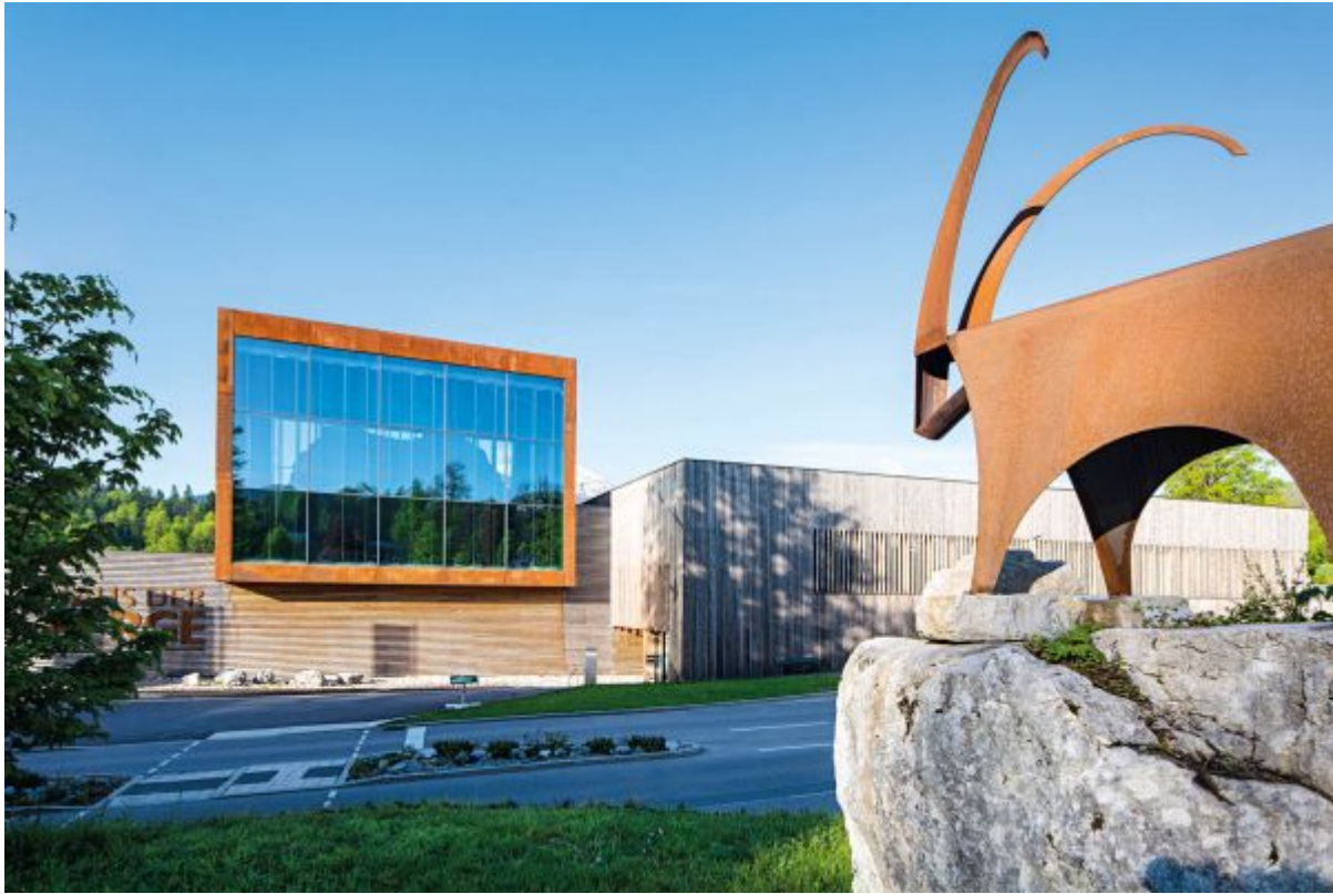
Nationalparkzentrum Haus der Berge
