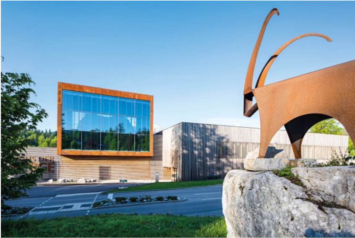
Nationalparkzentrum Haus der Berge
